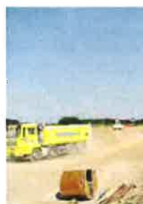
Porta dell'Expo, avviato il cantiere
