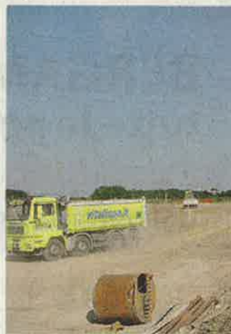
Porta dell'Expo, avviato il cantiere
