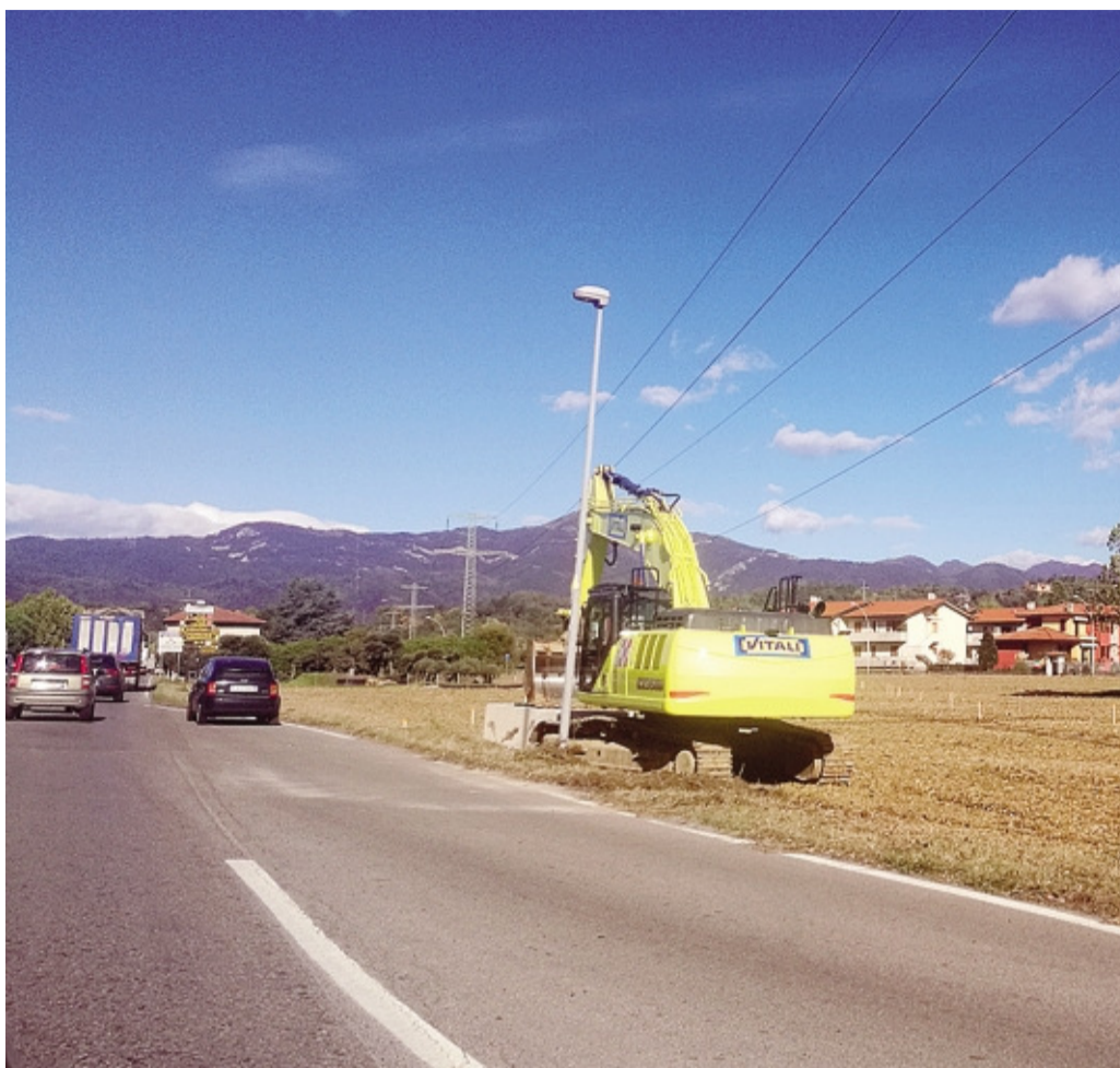
Mezzi al lavoro ieri a Valbrembo sul cantiere della Tangenziale Sud
