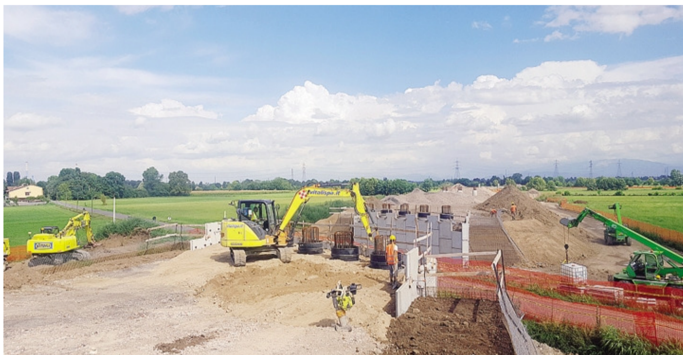
Nel cantiere della circonvallazione di Arzago e Casirate sono state portate alla luce tre necropoli di età Romana
