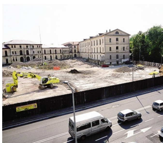
Demolizioni concluse alla Montelungo
